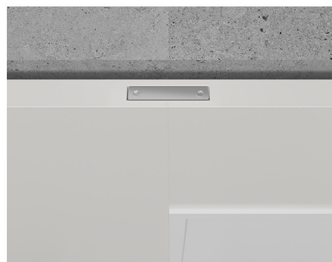
墙板与门头板连接点
